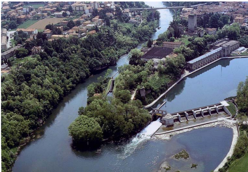
La centrale idroelettrica di Trezzo d'Adda di Enel Green Power
